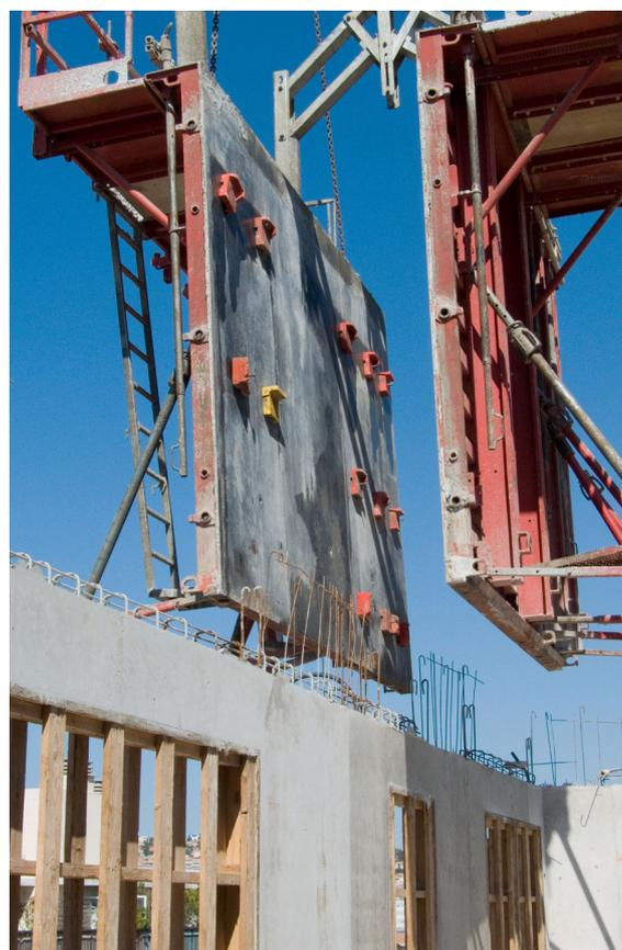
Chronolia est une gamme de bétons prêts à l'emploi fluides à durcissement rapide permettant un décoffrage très accéléré de tout élément de construction.
