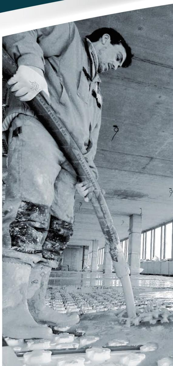
Livré sur chantier par camion malaxeur, Agilia Sols C est un mortier fluide à base de ciment pour la réalisation de chapes autonivelantes. Agilia Sols C est un produit de la gamme Le Système Sols de Lafarge Bétons.
