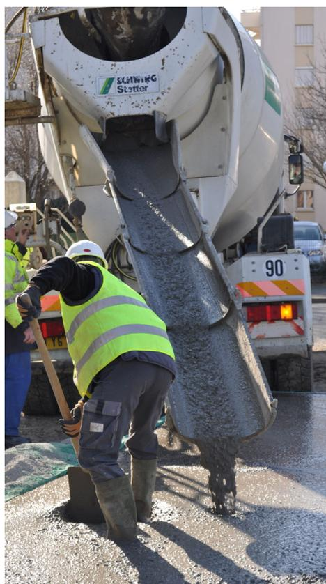
Agilia Horizontal est un béton autonivelant destiné à la réalisation de dallages ou de planchers de bâtiments.
