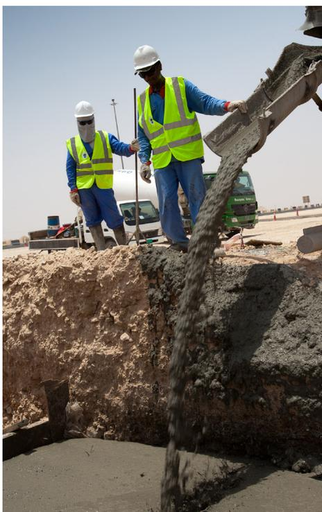
Agilia Fondations est un béton autoplaçant utilisé pour la réalisation de fondations de bâtiments.
