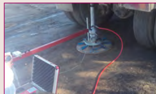
Contrôles in-situ : Vérification de la portance ou déflexion
