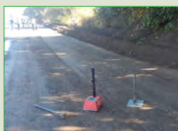
Vérification de la densité in situ
