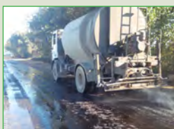
Protection : cure en émulsion avec gravillonnage
