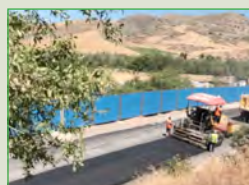
Réalisation couche(s) d'enrobé(s)
