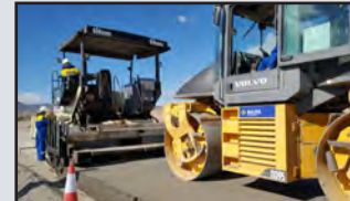
Mise en œuvre au finisseur par couches de 18 cm d'épaisseur maximale • Prévoir un retardateur pour assurer le collage frais sur frais si plusieurs couches • Prévoir une surépaisseur de foisonnement de l'ordre de 20 % avant compactage
