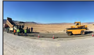
Acheminement en camions bennes bâchées (pour assurer le maintien de l'humidité)
