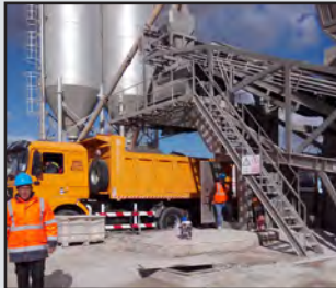
Production sous centrale béton ou centrale grave
