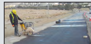
Réaliser des joints de retrait (pré-fissuration) par sciage
