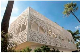
Ductal est un Béton Fibré à Ultra hautes performances (BFUP) de Lafarge Algérie, il offre une combinaison unique de caractéristiques techniques sans équivalent ; ductilité, résistance mécanique et durabilité, qui laisse libre cours à toute la créativité des architectes et concepteurs de bâtiment. L'élégance des formes minérales les plus épurées accessible, tout comme l'incontournable complexité des éléments multifonctionnels sans compromis esthétiques
