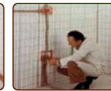
Réservation et câblage
