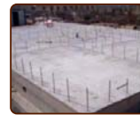
Installation des barres d'attentes
