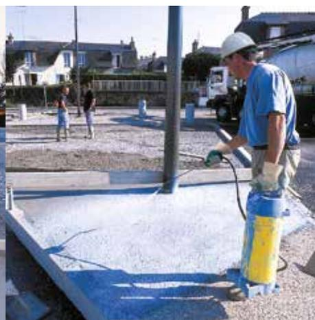
La technologie TMT (Time Mastering Technology) appliquée à la gamme Artevia est un concept de béton décoratif à durcissement rapide.
